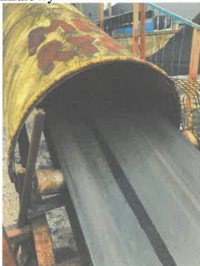
Fot nr 3 przedstawia osłonę taśmociągu mialowego
