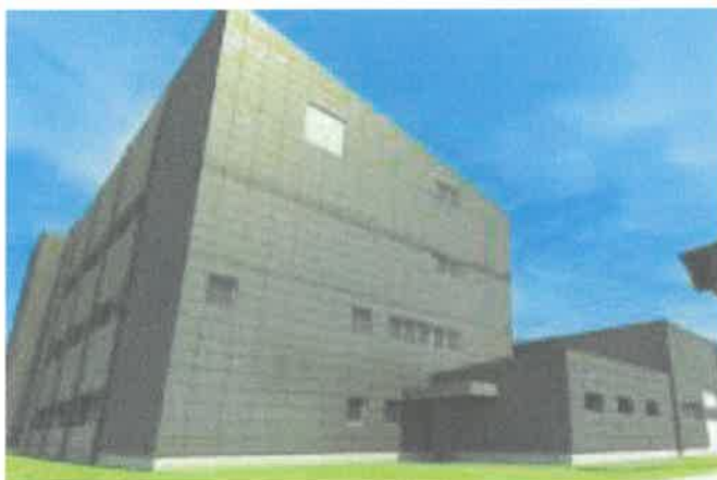
Zdjęcie nr 2 przedstawia budynek główny Ciepłowni Rypin
