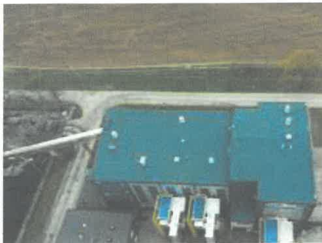
Zdjęcie nr 1 przedstawia kompleks budynków Ciepłowni
