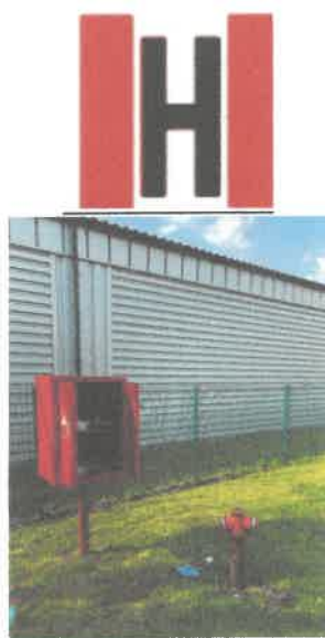
Fot Nr 13 przedstawia miejsce lokalizacji hydrantu zewnętrznego ze skrzynką na osprzęt hydrantowy
